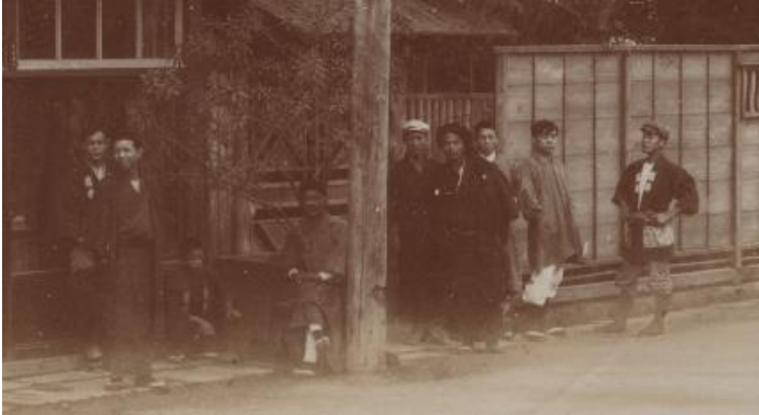
図 132. 磯谷商店外観（写真 227）（一部）
